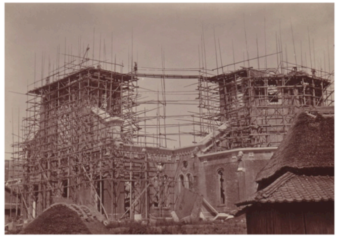
建設中の浦上教会堂/1912年 (パリ外国宣教会所蔵)
